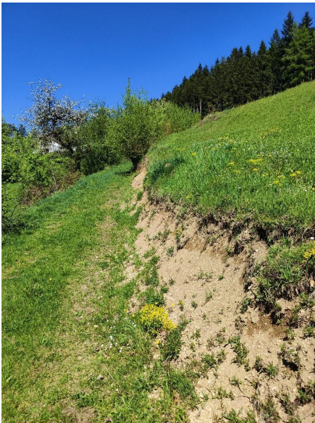
Abb. 13: Abbruchkante entlang eines Weges in der Kuhweide (Grabneralm, Kleinmaseldorf)
