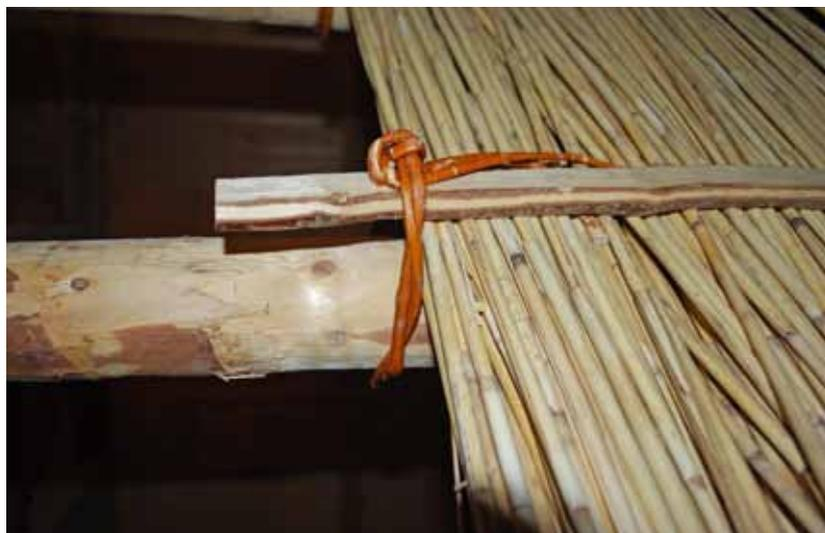
Mit Weide gebundene Haselholzspangen befestigen das Stroh- oder Schilfdach.
